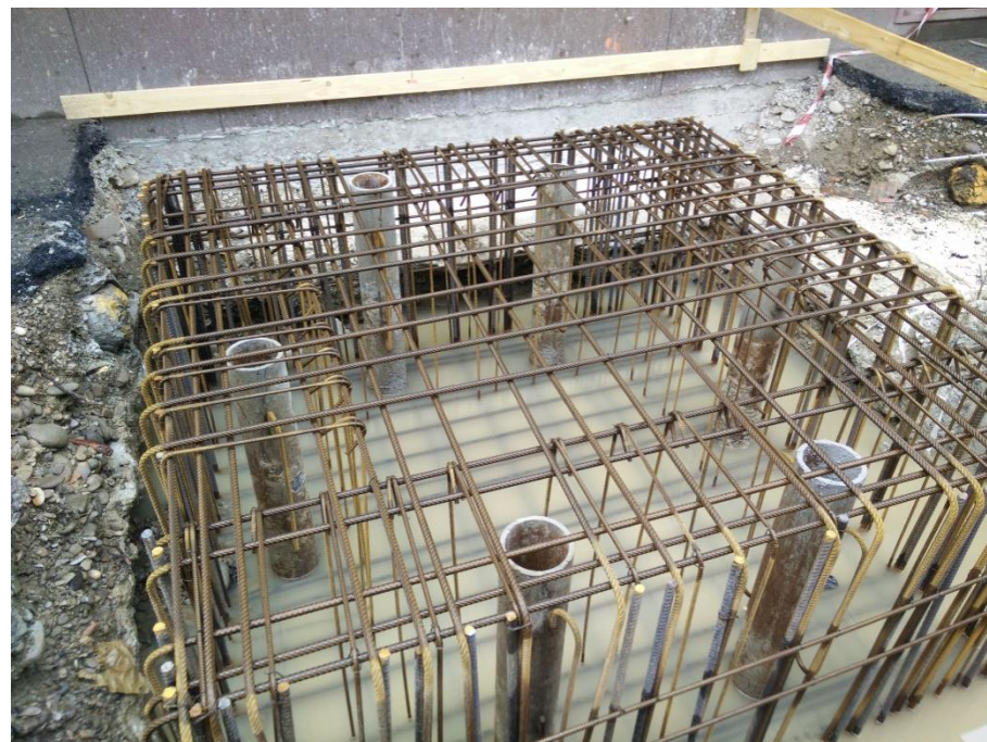
Strutture di fondazione
