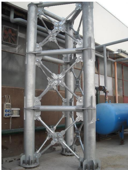
Strutture in elevazione
