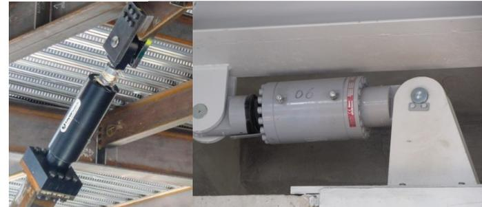
**DISPOSITIVI ANTISISMICI:** «... *elementi che contribuiscono a modificare la risposta sismica di una struttura, ad esempio incrementando il periodo fondamentale della struttura, modificando la forma dei modi di vibrare fondamentali, incrementando la dissipazione di energia, limitando la forza trasmessa alla struttura e/o introducendo vincoli permanenti o temporanei che migliorano la risposta sismica.*»
