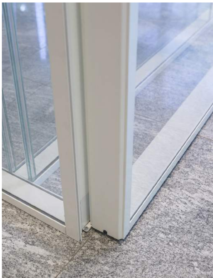
Dettaglio cerniera inferiore a scomparsa
